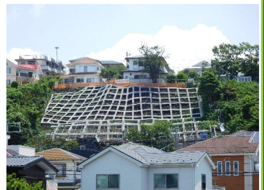
片瀬山一丁目斜面崩壊防止工事
