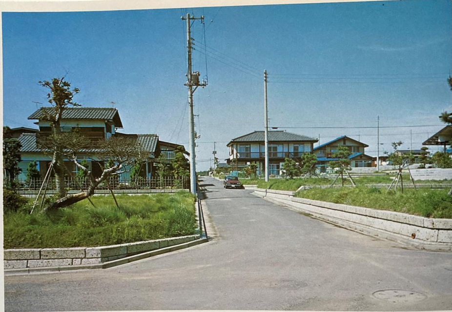
道路 基礎路盤の厚さ30cm、表層3～5cmもある完全舗装。中心から両サイドにかけて2%の勾配をつけ、水はけをよくしました。
