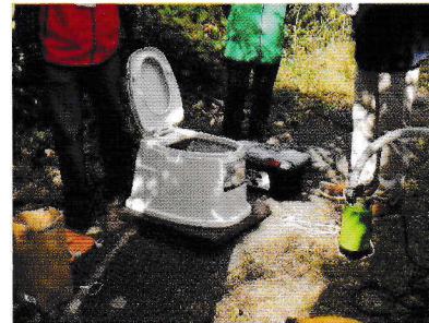
非常用マンホールトイレの設置
